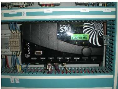
Passage en GPRS du satellite de télétransmission à la station de pompage de prés-Paris.
