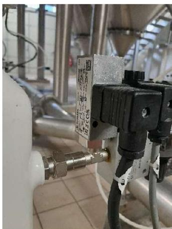
**Mars** Changement des capteurs de position (pressostat) des vannes à manchette VM1A et VM4A.
